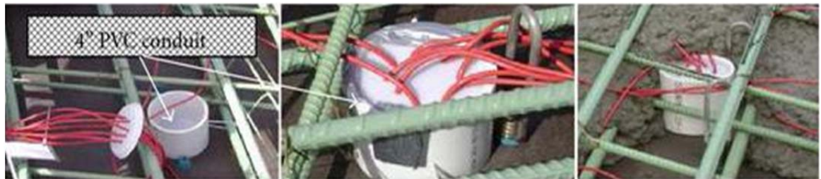
(b) Conduit placement
